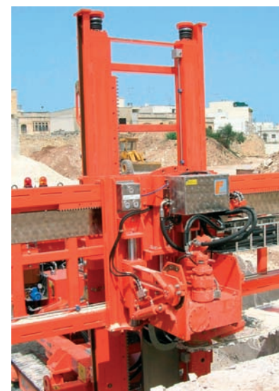
Segatrice semovente al lavoro in un cantiere di Malta
